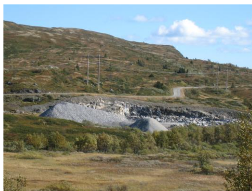
Anleggelse av steinbrudd/deponi på fjellet kan bidra til å redusere transportbelastningen fra dalen og opp på fjellet. Dette ligger like ved Skeikampen i Gausdal kommune (Foto: Ragnhild Sperstad).
