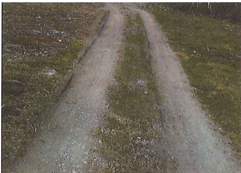
Eksempel på adkomstveg uten grøfter og skjæringer.
