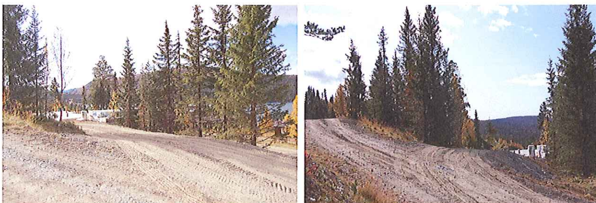
Eksempel på god terrengtilpasning ved etablering av adkomstveg til hyttetomt i N18 på Gålå.
