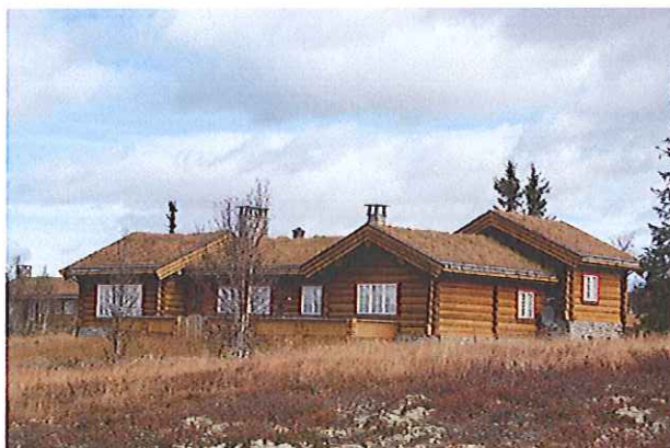
Saltak med markerte takutstikk, både på fjellet og nede i bygda.
