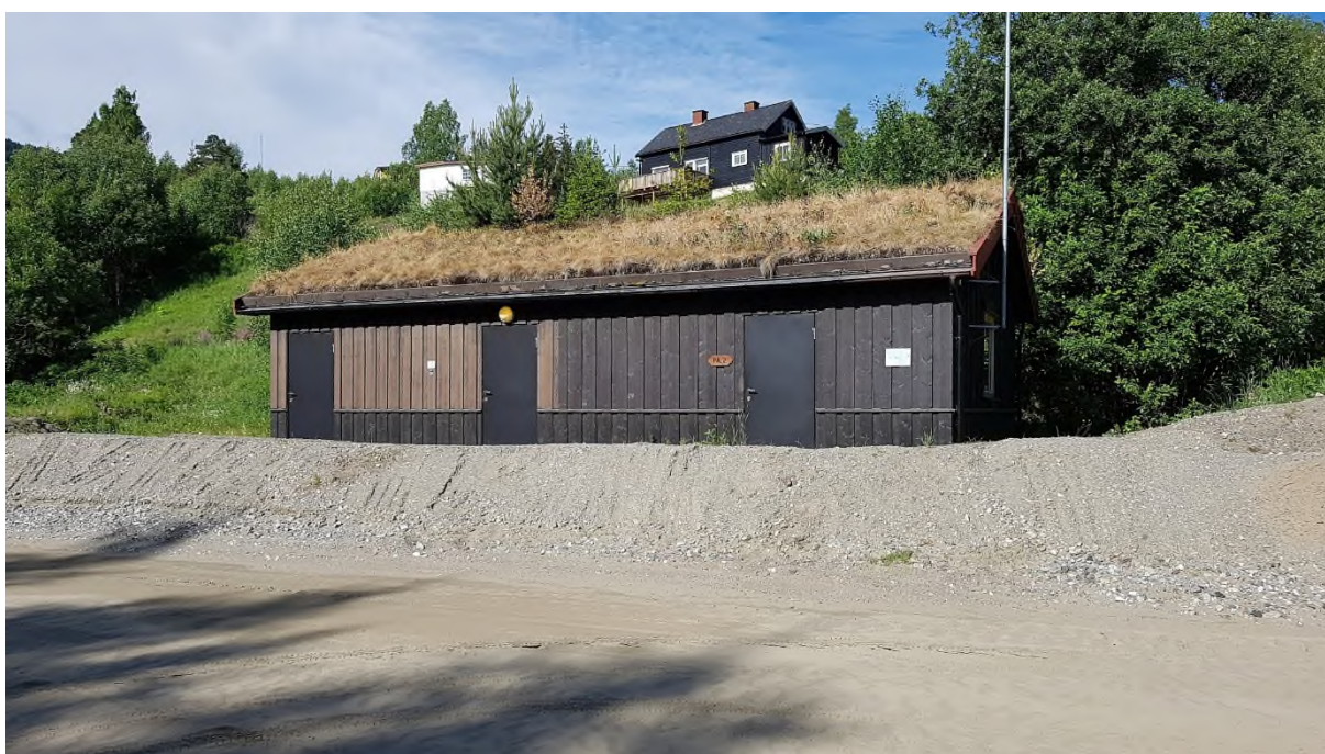
Bilde 76: Interkommunal pumpestasjon nedstrøms bilbru Klokkestranda
