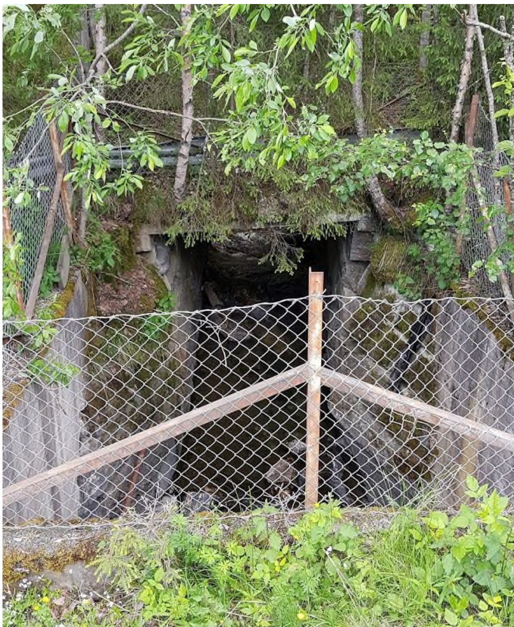
Bilde 22: Utløp kulvert under gammel veg og innløp vegkryssing Gålåvegen
