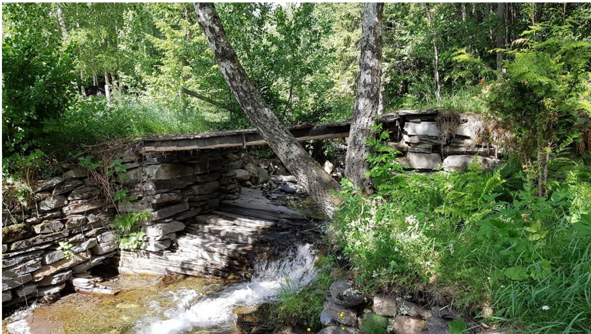
Bilde 65: Gangbru inn til hytte nedstrøms Vintervegen
