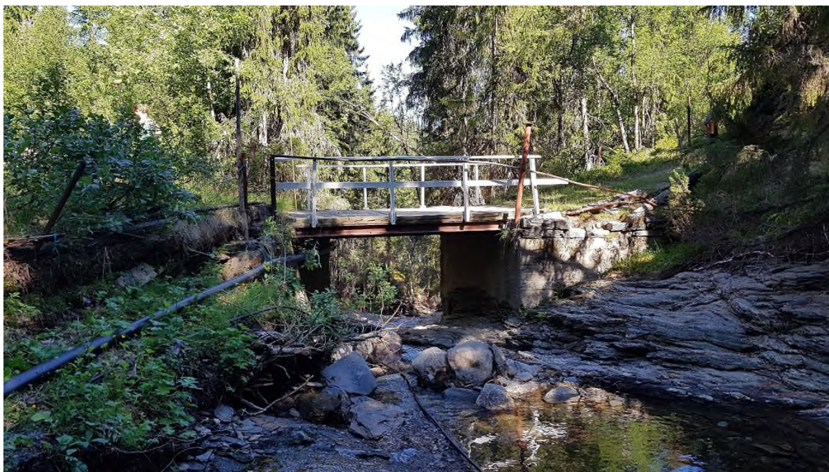
Bilde 19: Vegkrysning Baukholstulvegen 158, sett fra oppstrøms side
