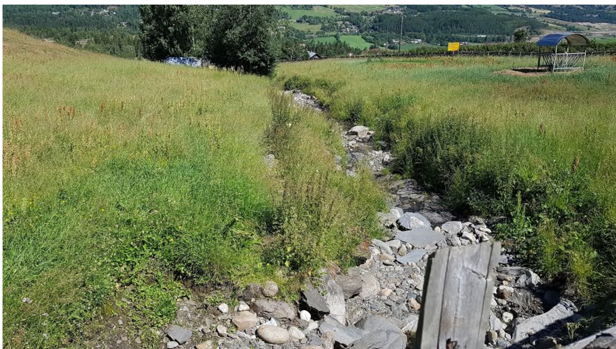
Bilde 83: Utløp vegkrysning gårdsveg oppstrøms Baksidevegen
