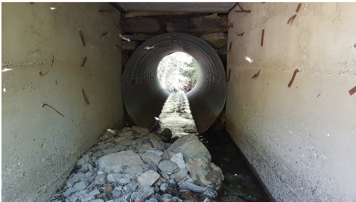
Bilde 15: Dimensjonsendring av kulvert i vegkrysning Baukholstulvegen
