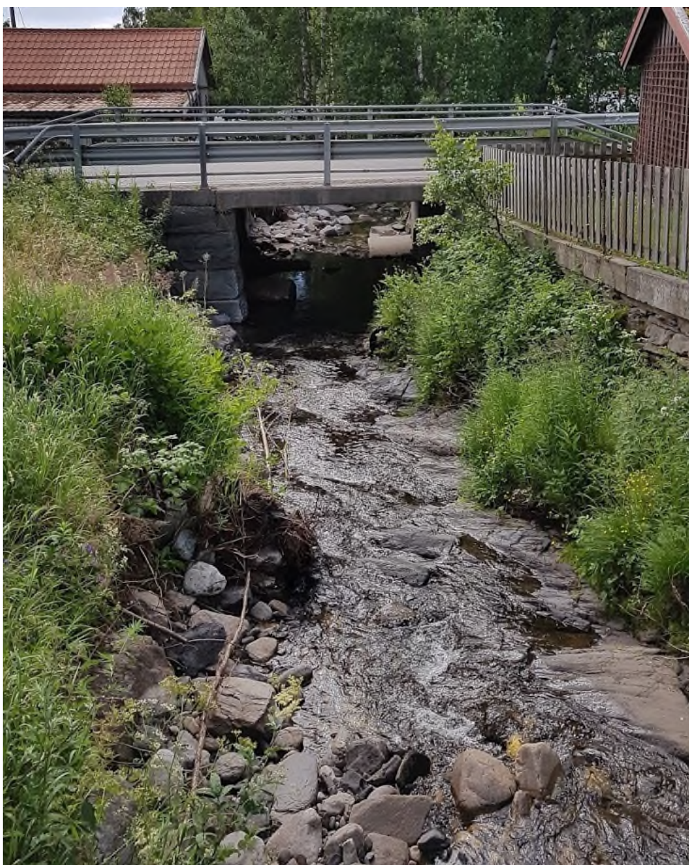
Bilde 56: Oppstrøms vegkrysning Gålåvegen
