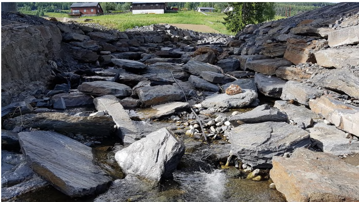
Bilde 72: Erosjonssikring under vegbru E6
