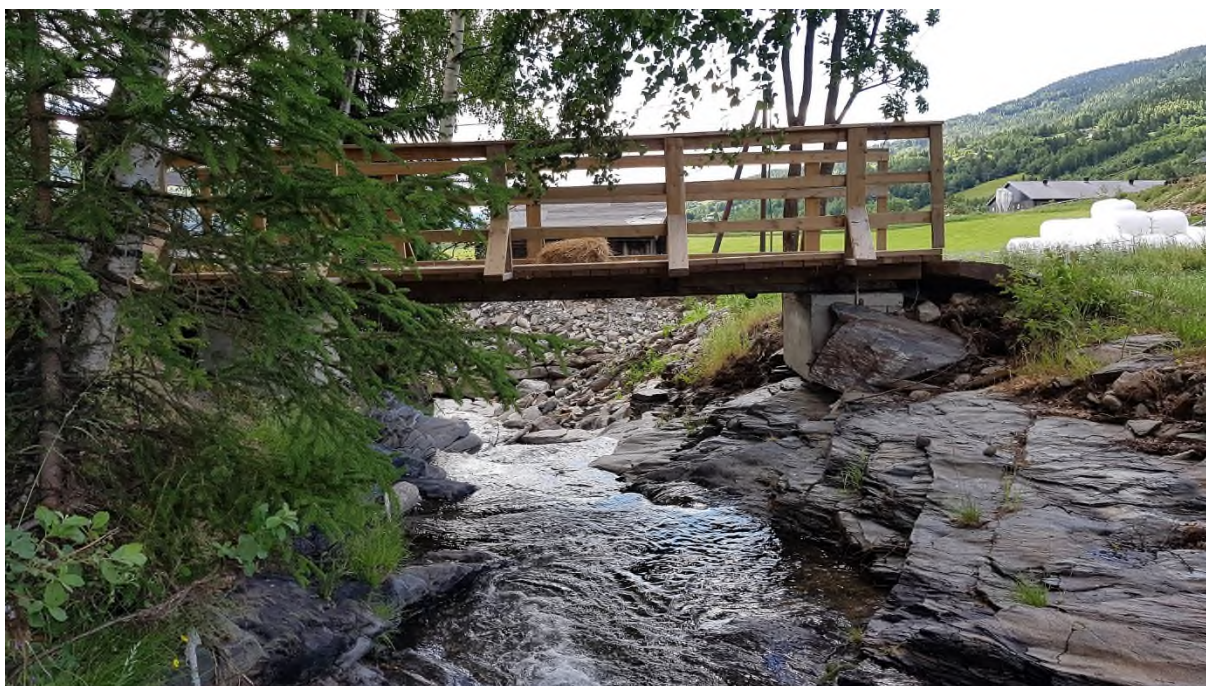
Bilde 58: Gangbru ved Harpefoss skule
