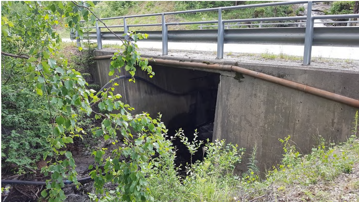
Bilde 49: Utløp kulvert vegkryssning Baksidevegen
