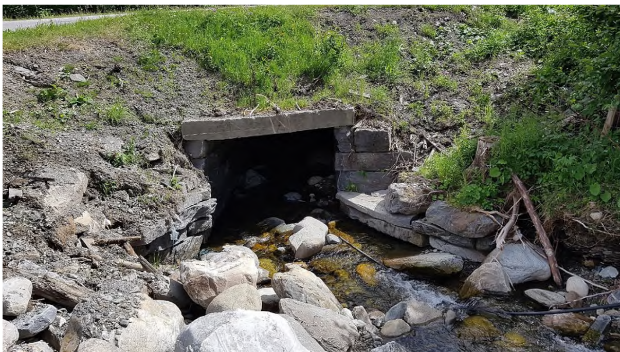
Bilde 27: Innløp vegkrysning Dålåstigen 467
