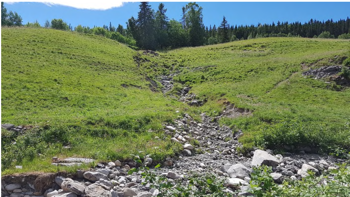
Bilde 92: Erosjonsskader fra sidebekk
