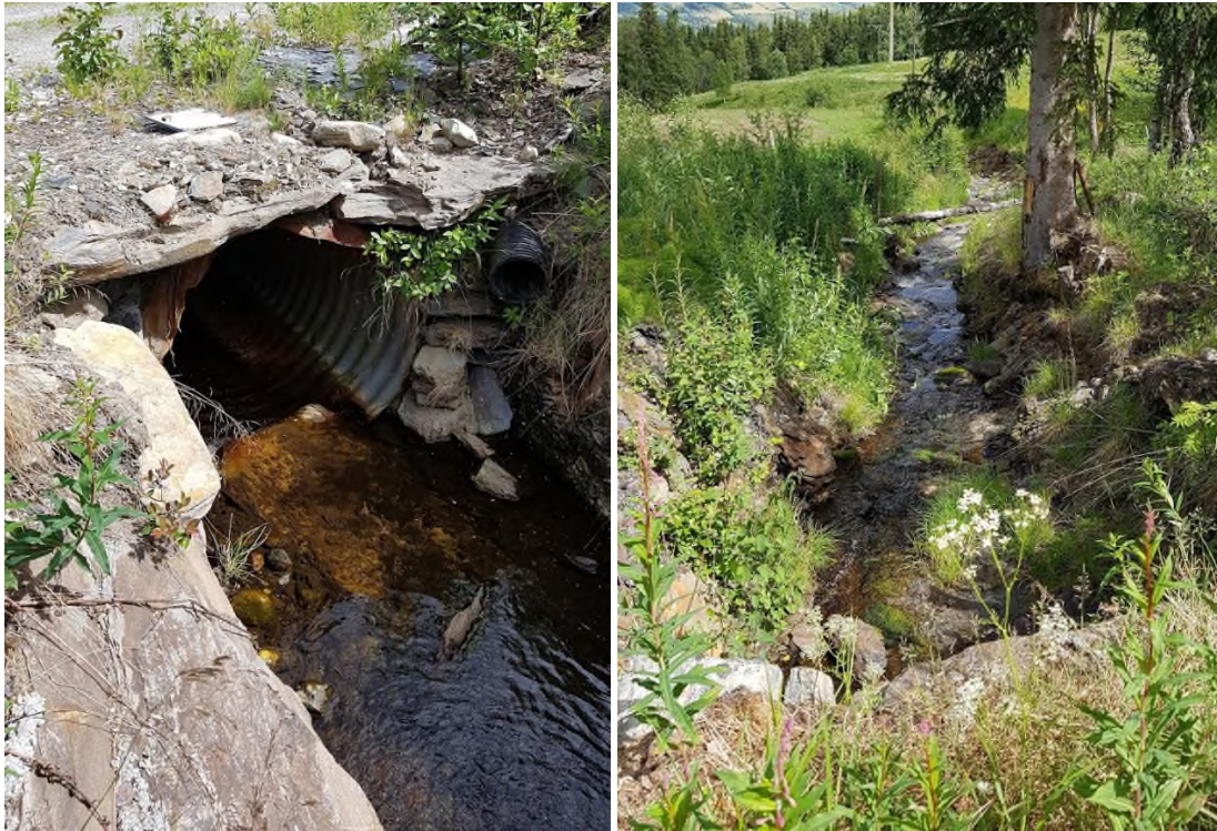
Bilde 90: Vegkrysningen inn til Dalsbaukhol, innløp til venstre, nedstrøms utløp til høyre
