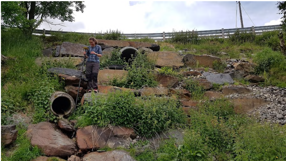
Bilde 88: Vegkrysning ved Enge gård
