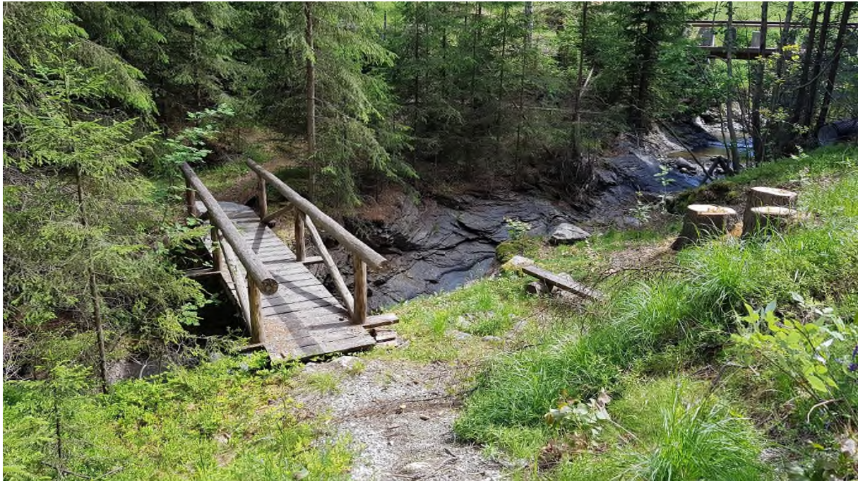
Bilde 41: Gangbru over Skurdalsåa rett nedstrøms Gammelskulevegen
