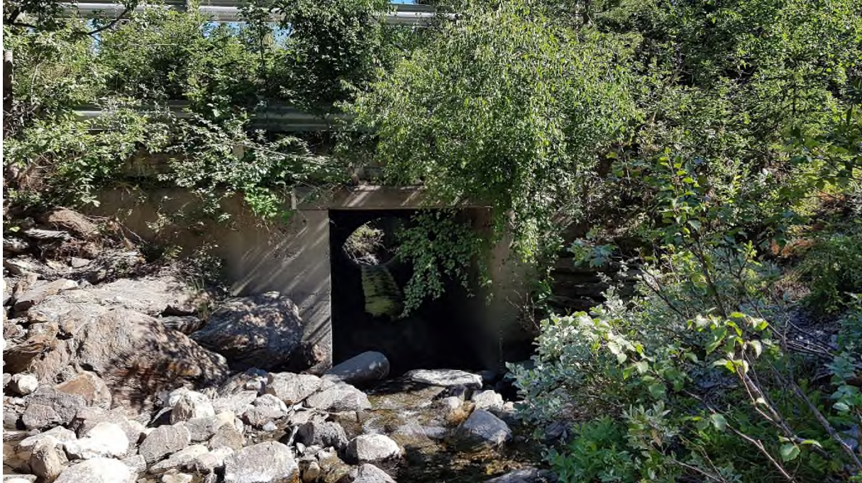
Bilde 16: Innløp kulvert vegkryssing Baukholstulvegen
