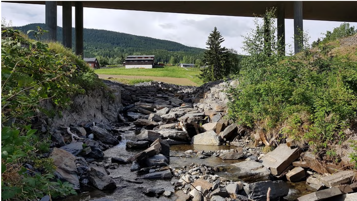
Bilde 71: Skurdalsåa under og nedstrøms vegbru E6
