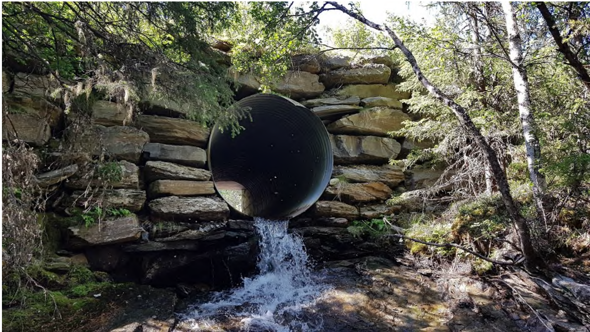
Bilde 17: Utløp vegkrysning Baukholstulvegen
