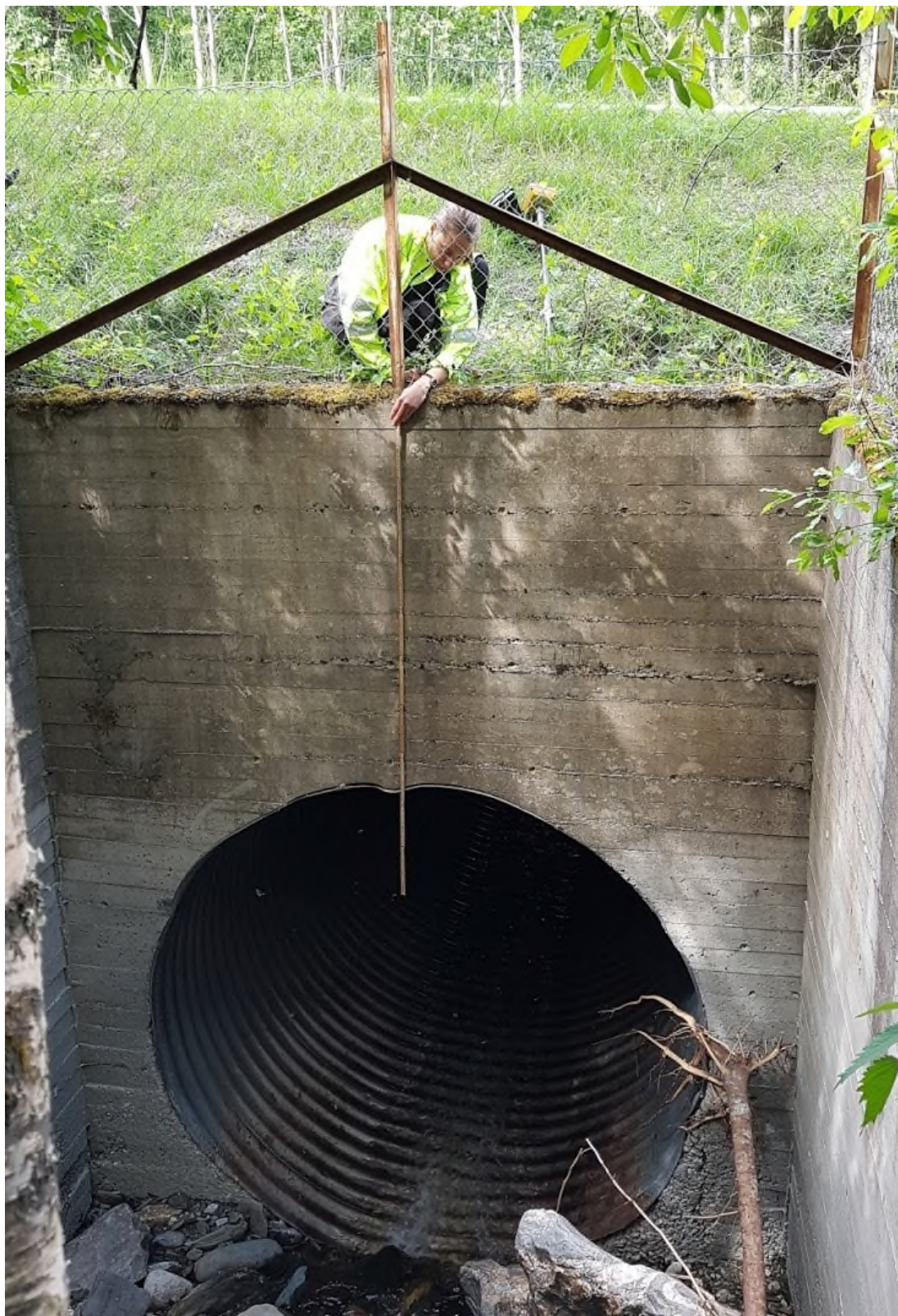
Bilde 23: Innløp vegkrysning Gålåvegen
