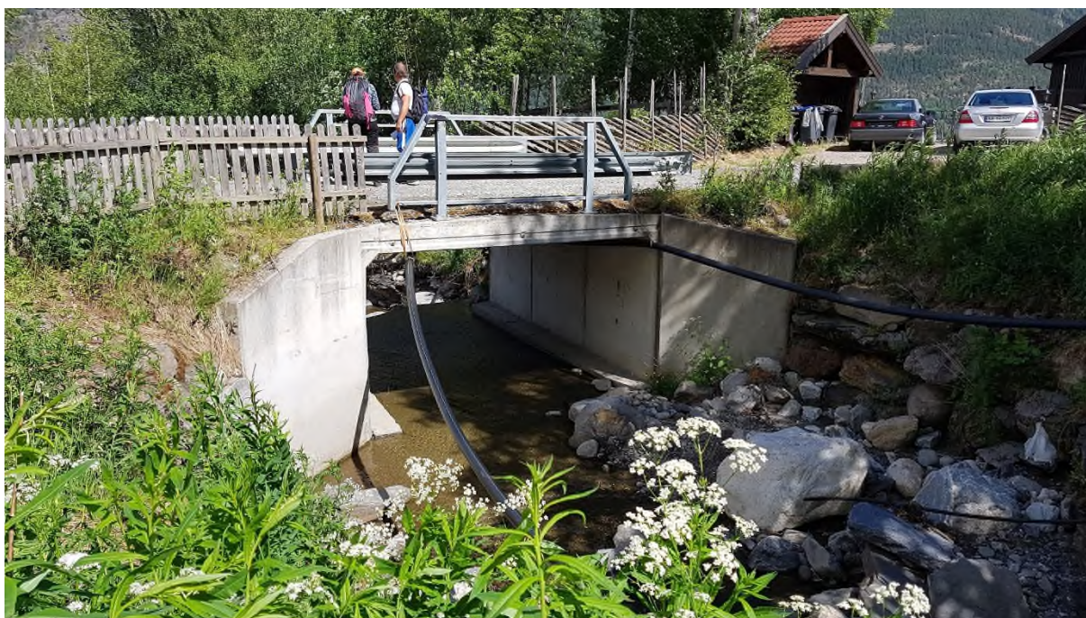
Bilde 45: Kulvert ved vegkrysning Gammelskulevegen
