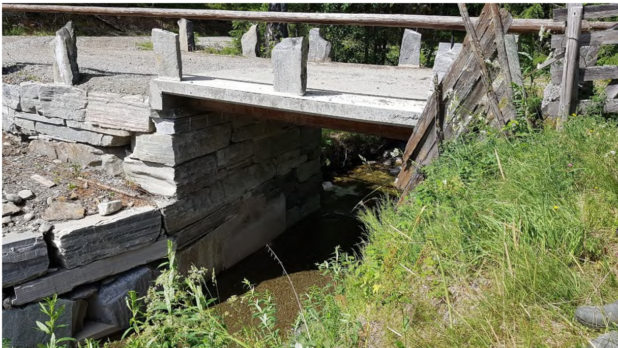
Bilde 38: Innløp bilbru i Gammelskulevegen
