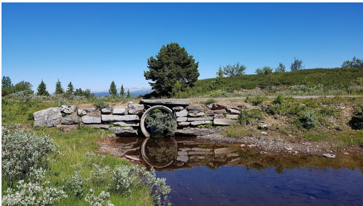
Bilde 9: Innløp vegkrysning Grønsletta
