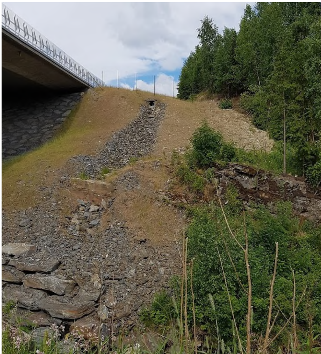
Bilde 70: Stikkrenne fra E6 nedstrøms side av brua
