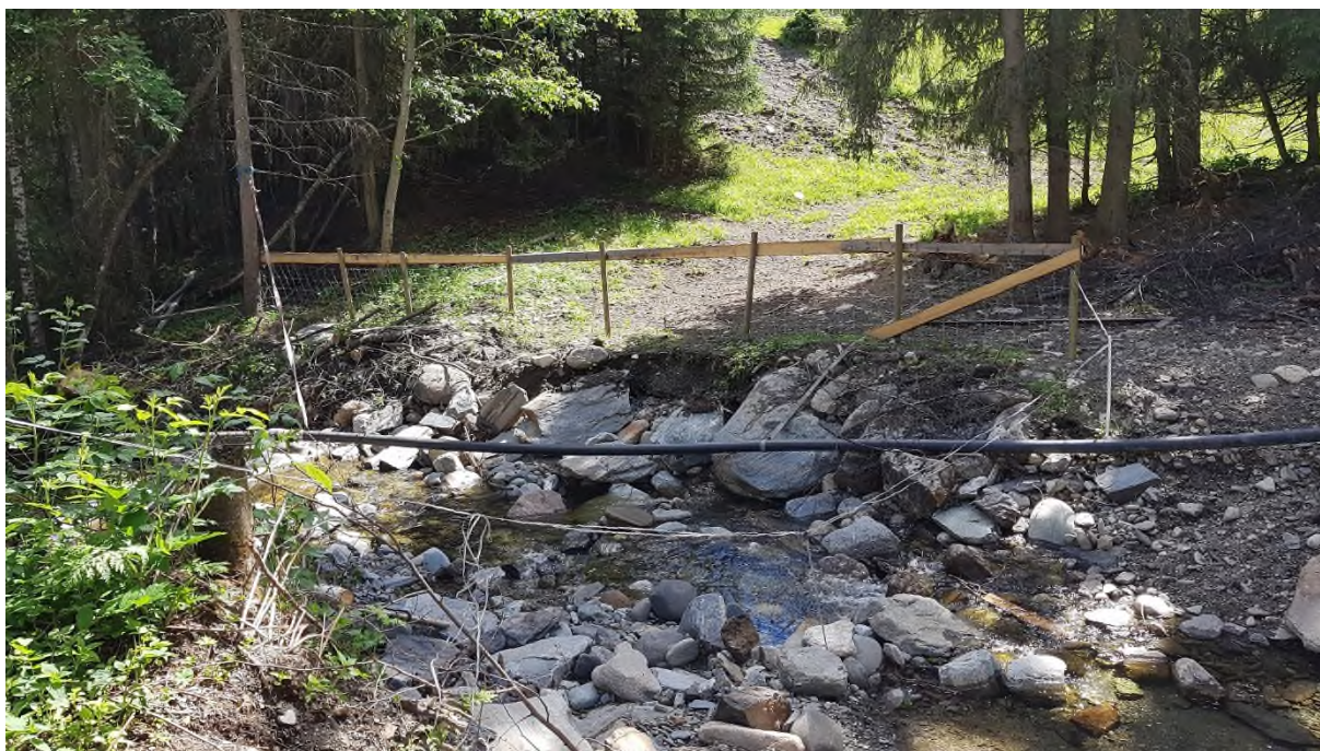
Bilde 36: Krysning av traktorveg nedenfor Torgerhaugen, sett nedstrøms.
