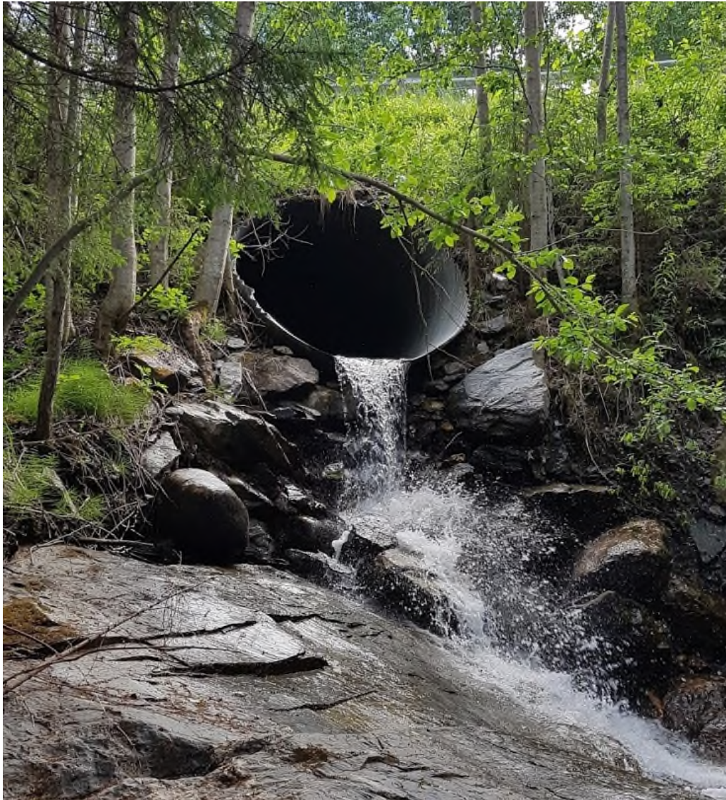
Bilde 24: Utløp vegkrysning Gålåvegen
