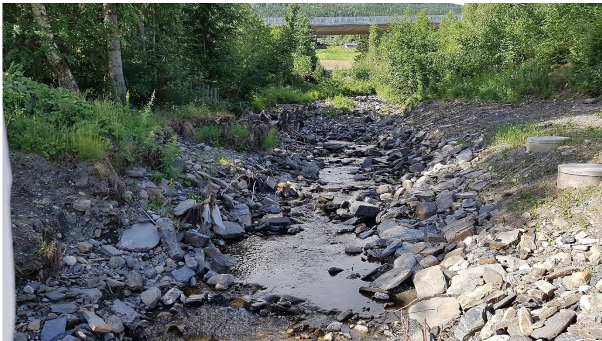
Bilde 73: Oppstrøms bilbru Klokkestranda sett mot E6-brua.
