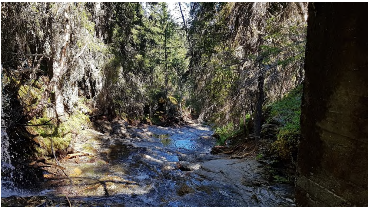
Bilde 21: Nedstrøms utløp vegkrysning Baukholstulvegen 158
