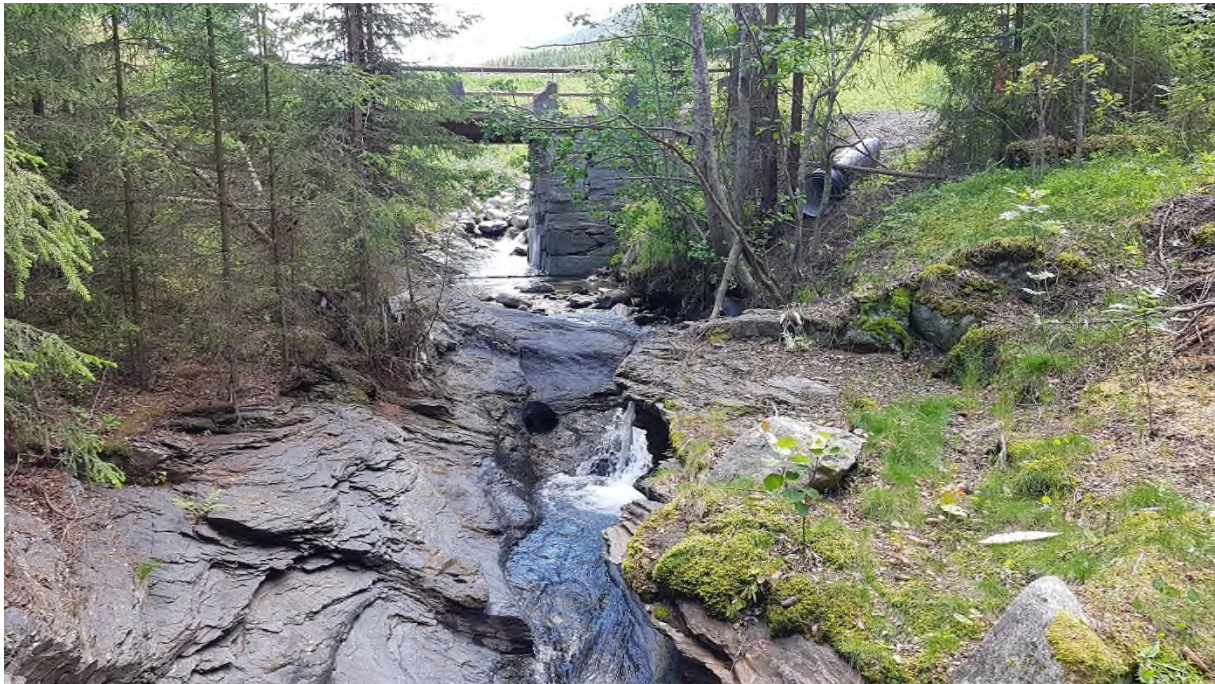
Bilde 39: Nedstrøms vegbru Gammelskulevegen, sett fra gangbru
