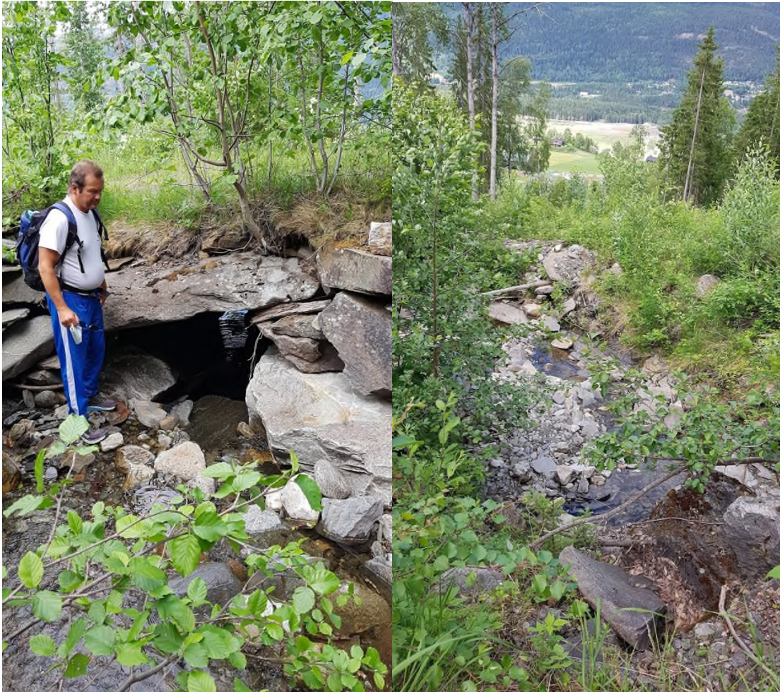
Bilde 79: Viser kryssning av traktorveg ovenfor Gålåvegen. Innløp til venstre og utløp til høyre.
