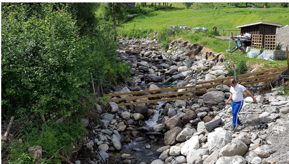
Bilde 29: Oppstrøms vegkrysning Dålåstigen 467
