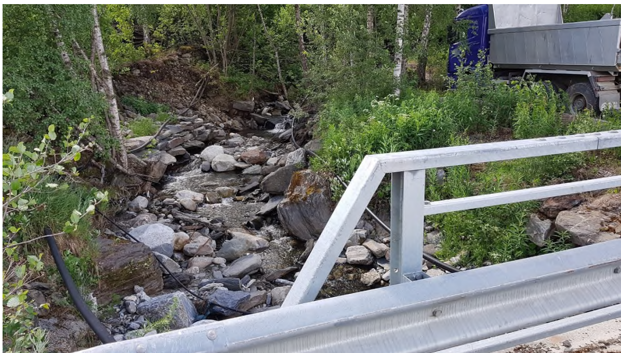
Bilde 46: Oppstrøms kulvert Gammelskulevegen
