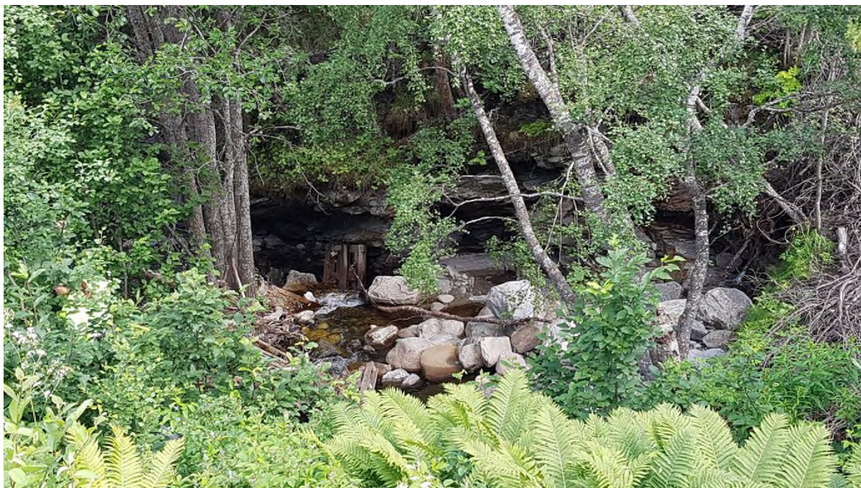
Bilde 30: Nedstrøms utløp vegkryssning Gålåvegen 467
