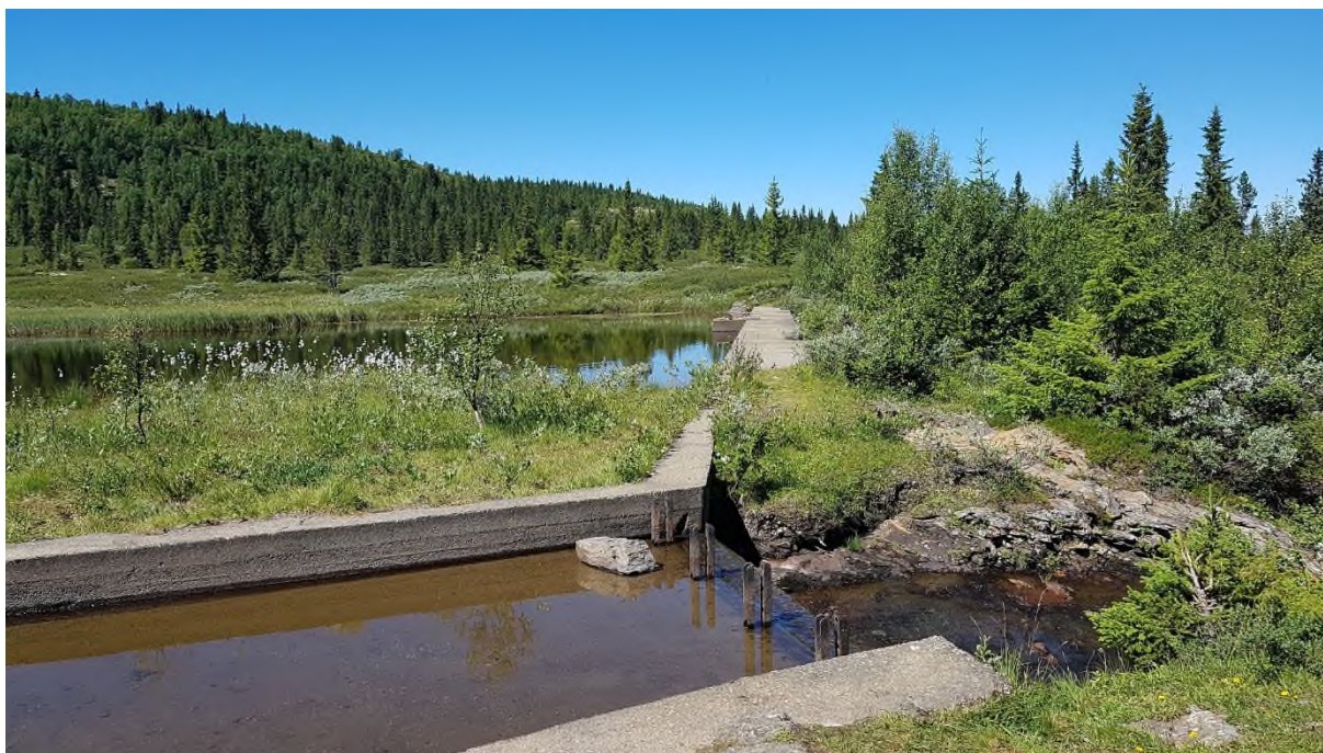
Bilde 5: Oppdemt tjern mellom Baukholstulvegen og Grønsletta. Hovedutløp, overløp høye side dam, medstrøms retning
