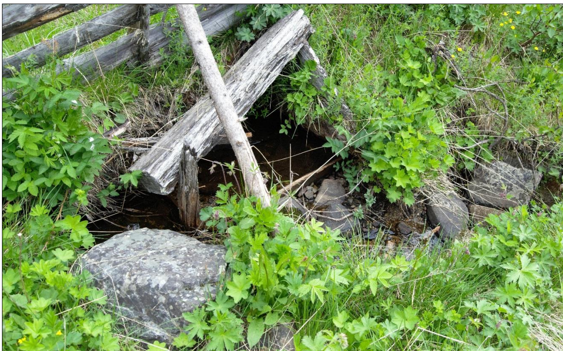
Mjølkekjøling og mjølkerampe på Øvre Frøysesetra i Gausdal, og restar av ei mjølkekjøle ved Øygaardsetra. Her må ein veta kva ei kjøle er for å forstå dei restane ein finn i landskapet.
