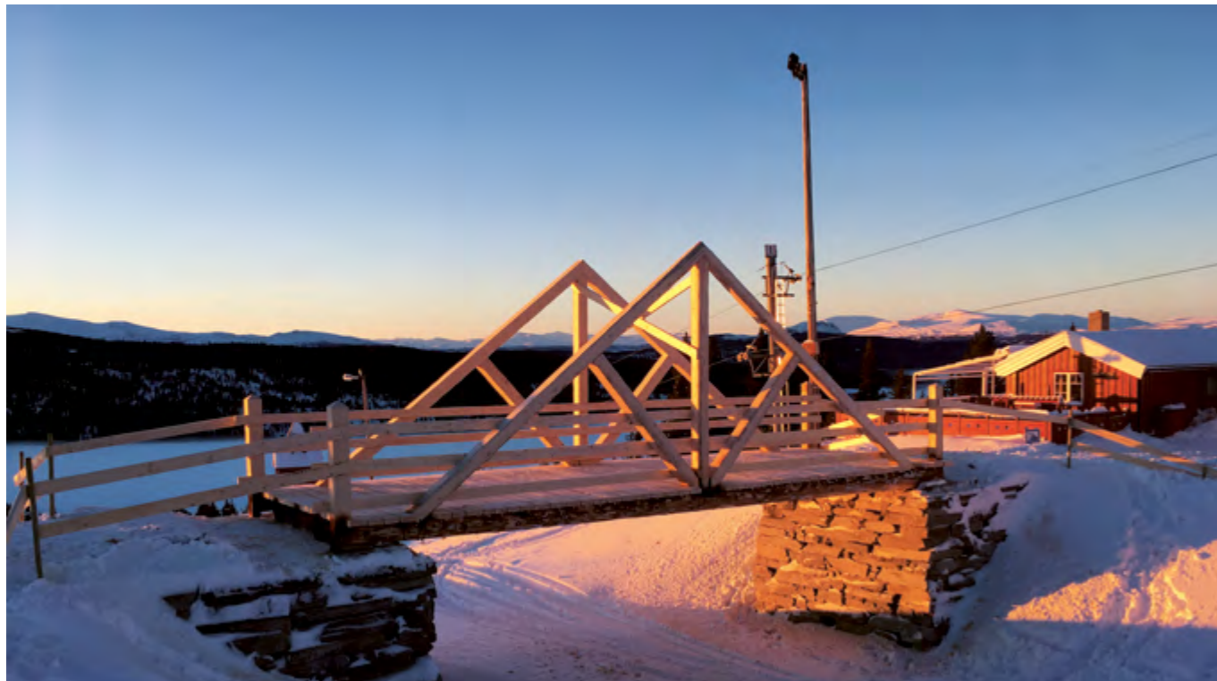
Den nye trebrua på Gålå, del av bygd gangveg fra Gålå Handel til Langslåvegen. Foto: Steinar Moldal.
