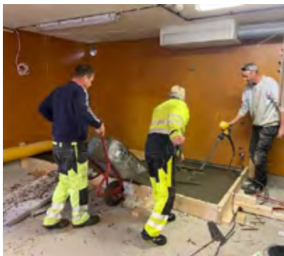
Fra arbeidet med ombyggingen.
