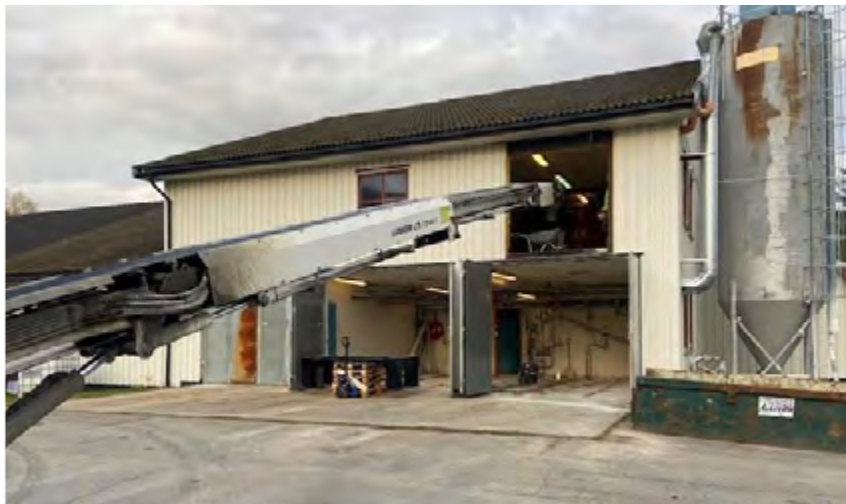
Byggetrinn 3 ved Frya Renseanlegg blir slutført i 2021.
