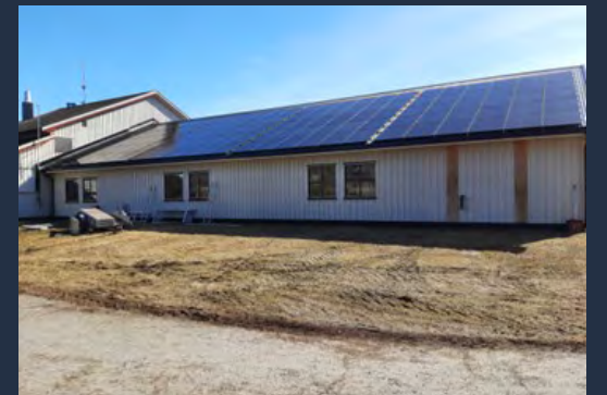
På grunn av høye strømkostnader er det montert solcelleanlegg på Frya Renseanlegg. Foto: Åge Øverjordet
