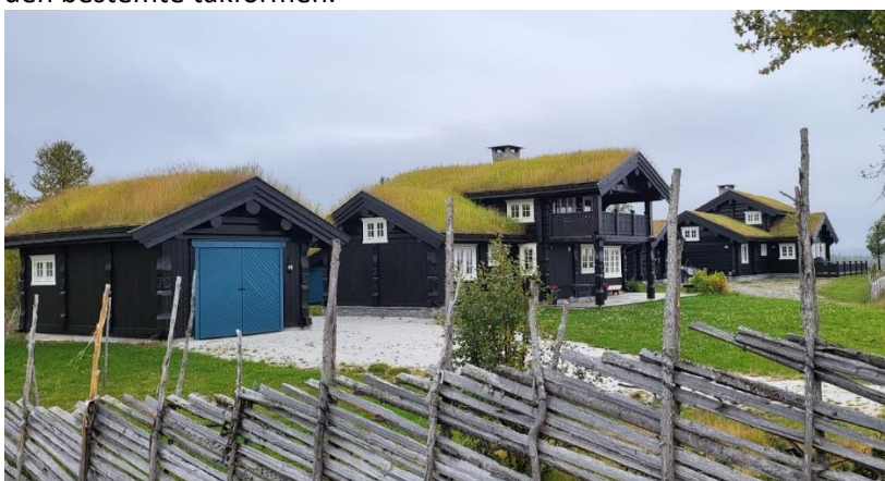
Saltak med markerte takutstikk både på fjellet og i bygda.
