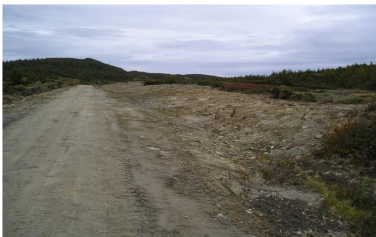
Eksempel på hvordan fjerning av vegetasjon gir et skjemmende preg i forhold til landskapet.
